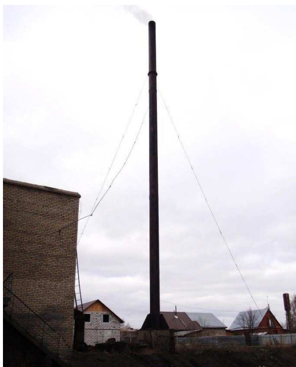
Рисунок 1.57 – Дымовая труба котельной Восток
