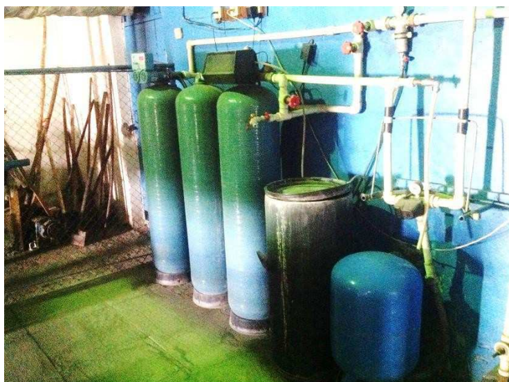
Рисунок 1.13 – Система водоподготовки котельной Н. Бровина
