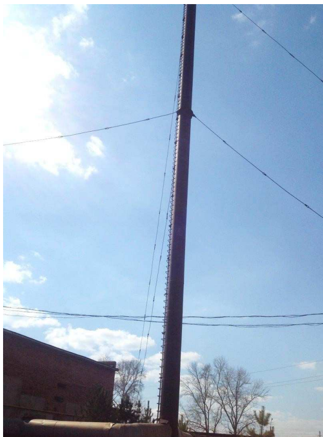
Рисунок 1.14 – Дымовая труба котельной Н. Бровина
