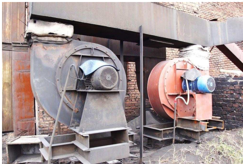
Рисунок 1.52 – Тягодутьевое оборудование котельной Ростелеком
