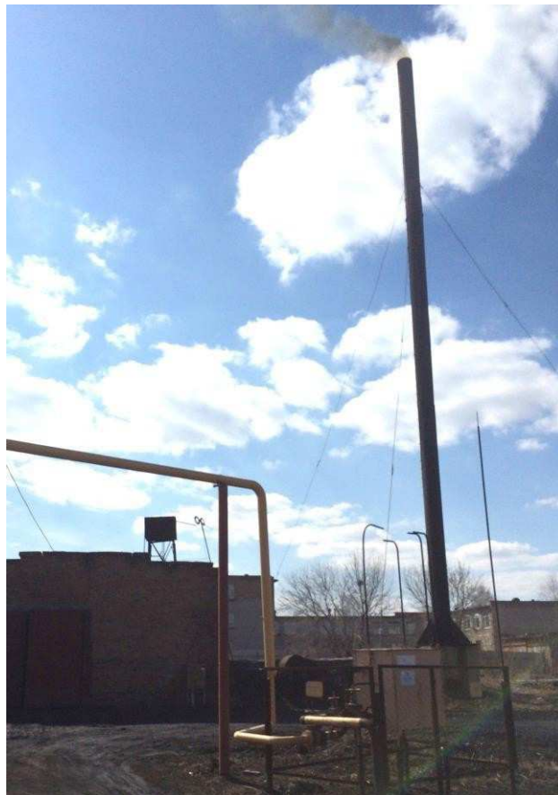
Рисунок 1.35 – Дымовая труба котельной школы №13
