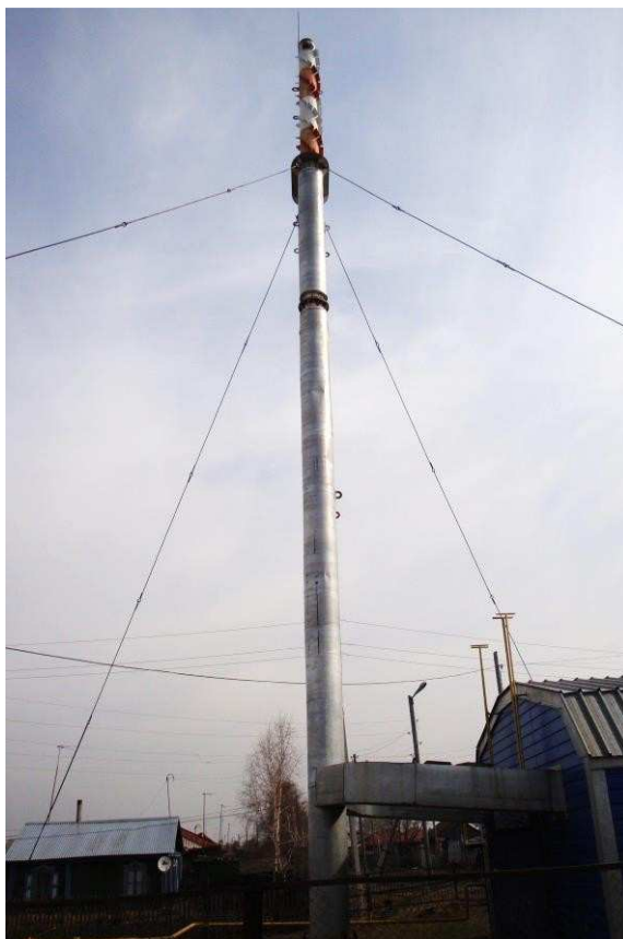
Рисунок 1.45 – Дымовая труба котельной ЦРБ
