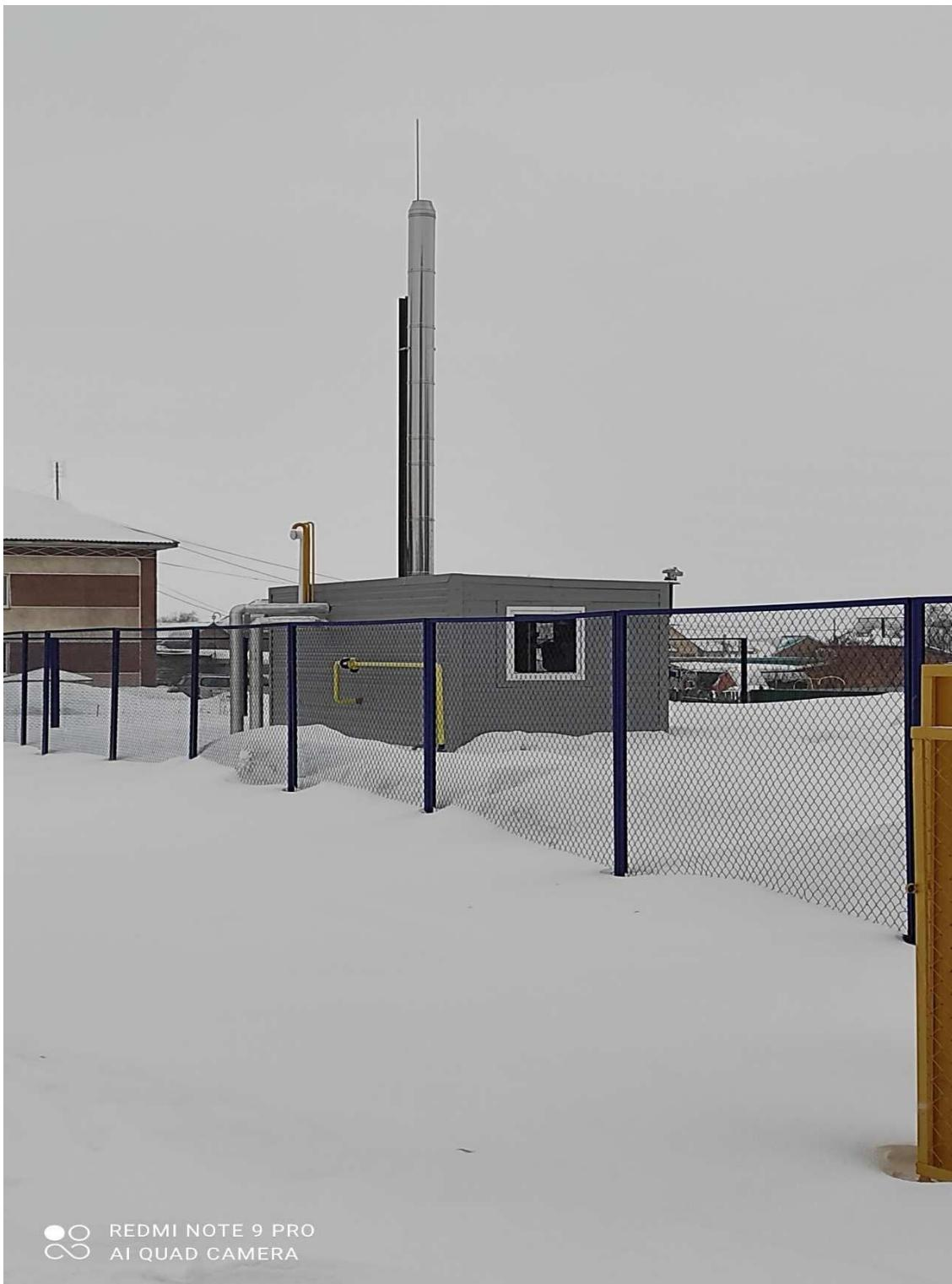
Основным видом топлива котельной является газ. Аварийное топливо – дизтопливо.
