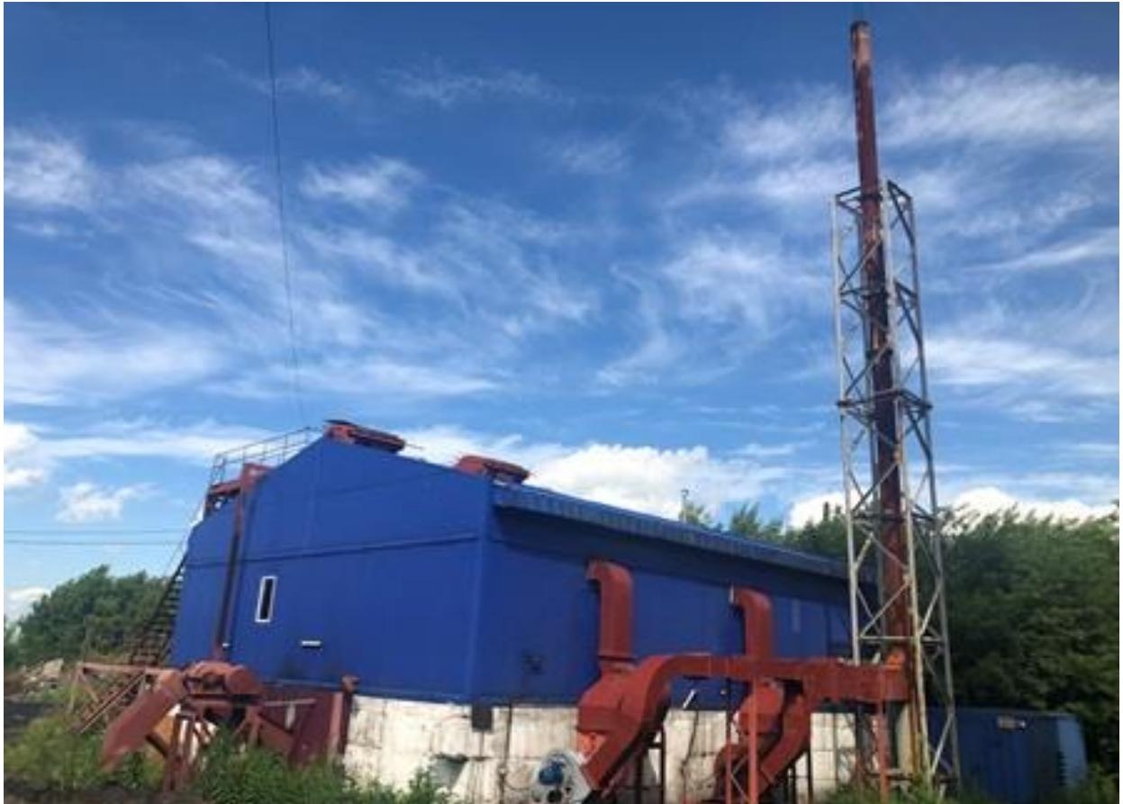
Основным видом топлива котельной является уголь. На резерв имеется два фидера и дизельгенератор. Котельная оборудована котлами «КВм-1,25КБ». В таблице 1.7 приведены данные о котельном оборудовании, установленном на котельной РТП.
