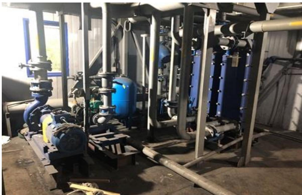
Котельная работает по независимой схеме, для приготовления теплоносителя на нужды отопления и вентиляции установлены аппараты теплообменные пластиинчатые разборные производства ЗАО «Ридан».
