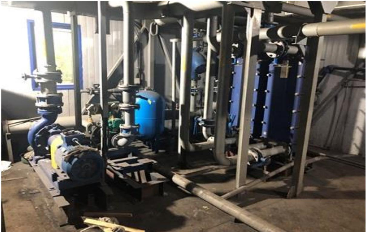
Котельная работает по независимой схеме, для приготовления теплоносителя на нужды отопления и вентиляции установлены аппараты теплообменные пластинчатые разборные производства ЗАО «Ридан».
