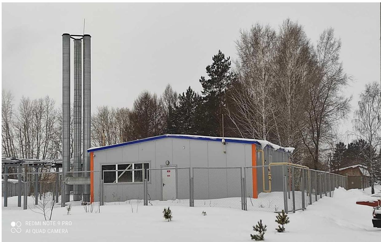
Основным видом топлива котельной является газ. Аварийное топливо – диз.топливо.
